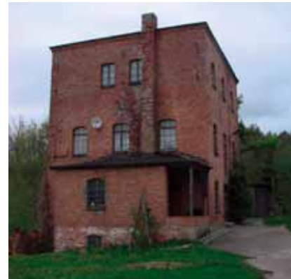
Mała elektrownia wodna w starym młynie w Białogardzie (woj. pomorskie)
