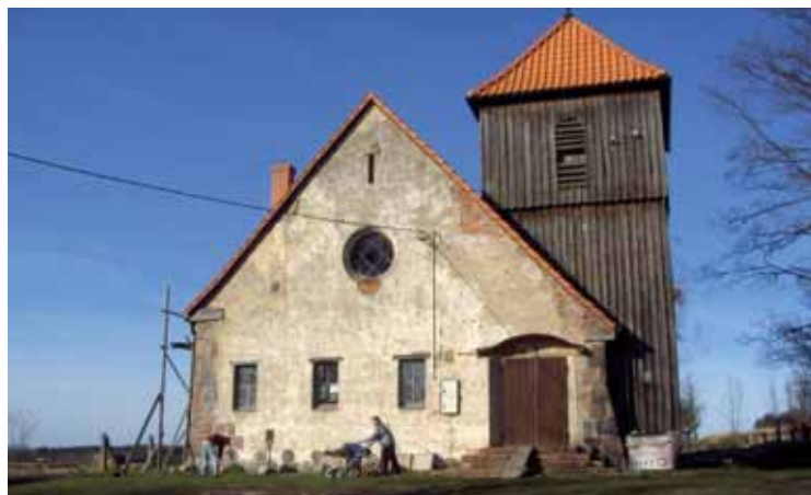
Kościół ewangelicki w trakcie adaptacji na świetlicę, Klon (woj. warmińsko-mazurskie)
