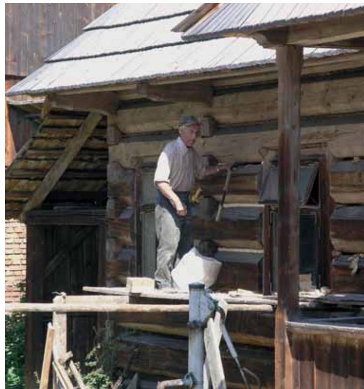
Góralski cieśla w Chochołowie wymienia w starym budynku słomiane warkocze uszczelniające styki bierwion zrębu chaty podhalańskiej (woj. małopolskie)
