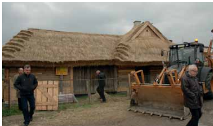
Chata w trakcie odbudowy, kwiecień 2010
