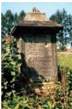
Stan zachowania cokołu
