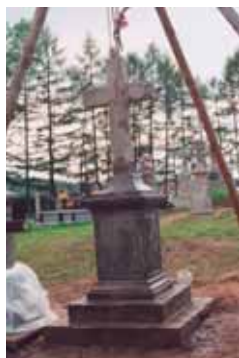
Stan tuż przed zakończeniem remontu
