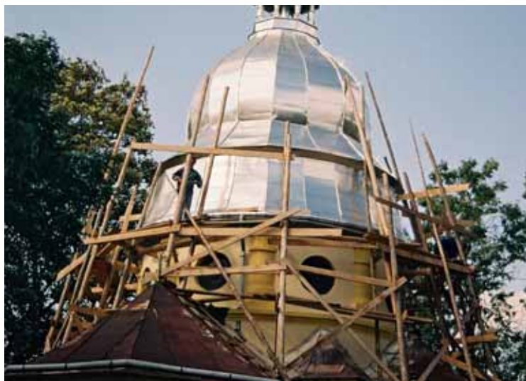
Cerkiew w trakcie remontu
