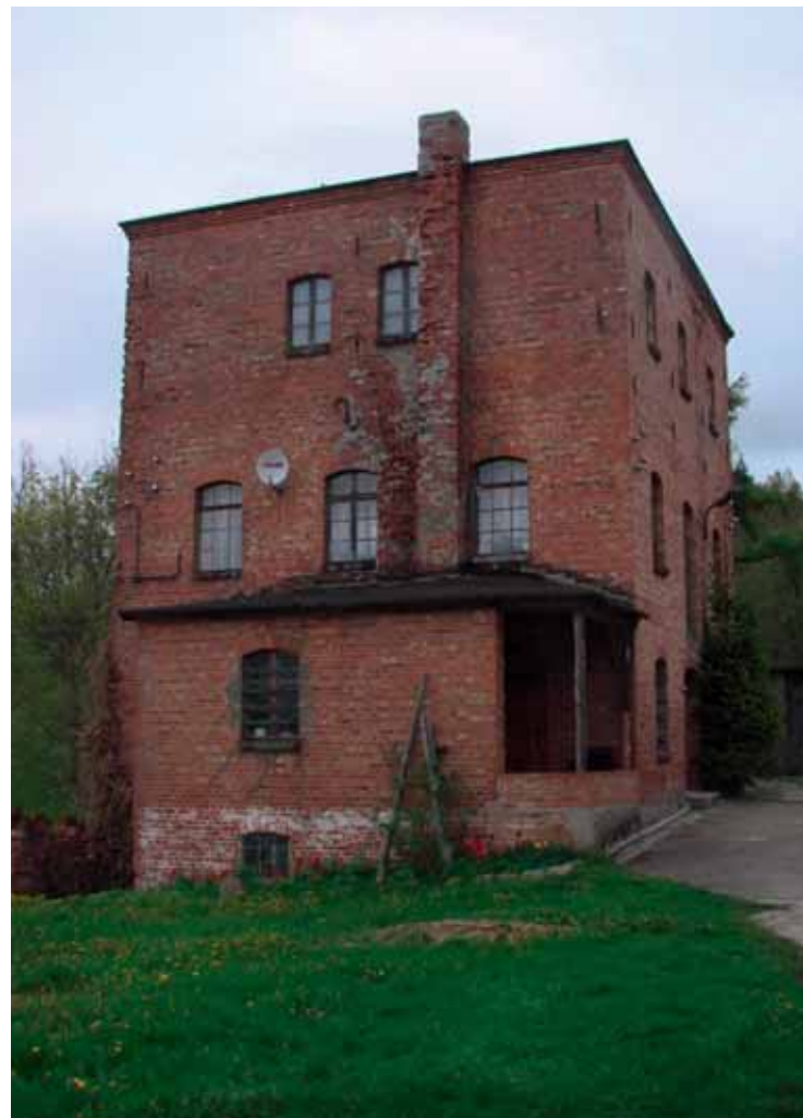
Mała elektrownia wodna w starym młynie w Białogardzie (woj. pomorskie)
