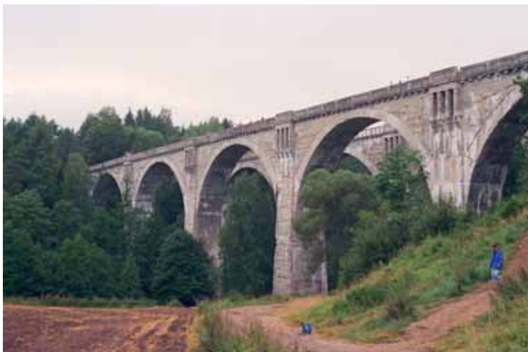
Wiadukty nieczynnej linii kolejowej Gołdap-Żytkiejmy w okolicach wsi Stańczyki (woj. warmińsko-mazurskie)
