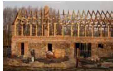
Oboro-stajnia w trakcie i po remoncie
